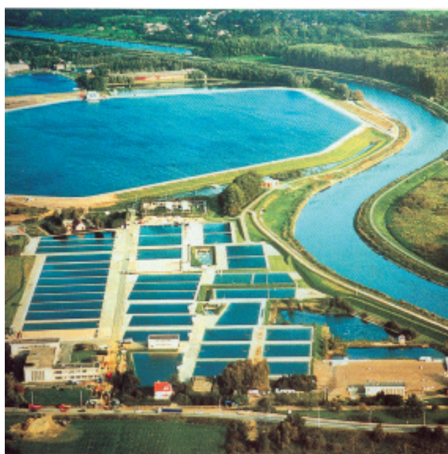
De putten van de AWW te Walem aan de Nete.
