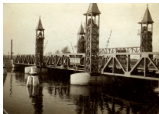
De stalen brug, met in het midden een ophaalbaar gedeelte, door de genietroepen opgeblazen op 17 mei 1940
