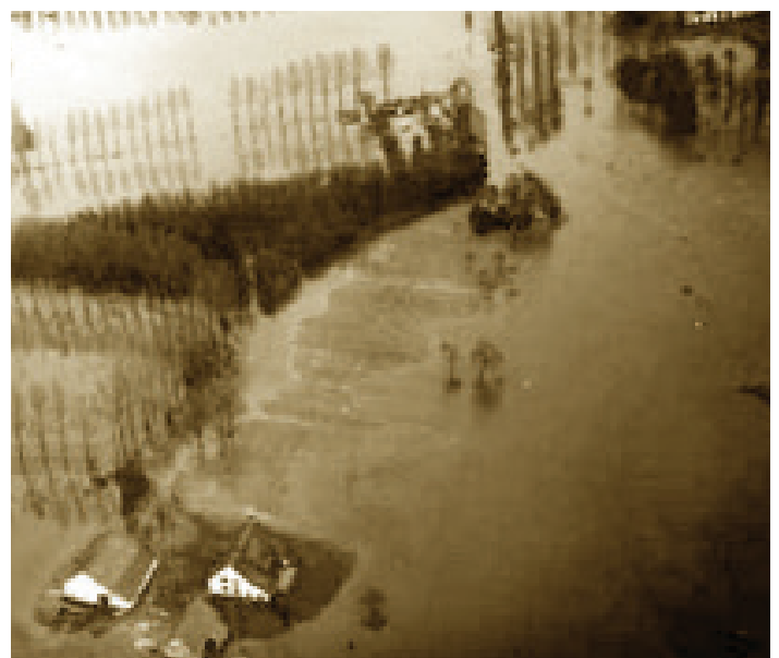
Een zicht op de overstroomde woningen in Battenbroek.
