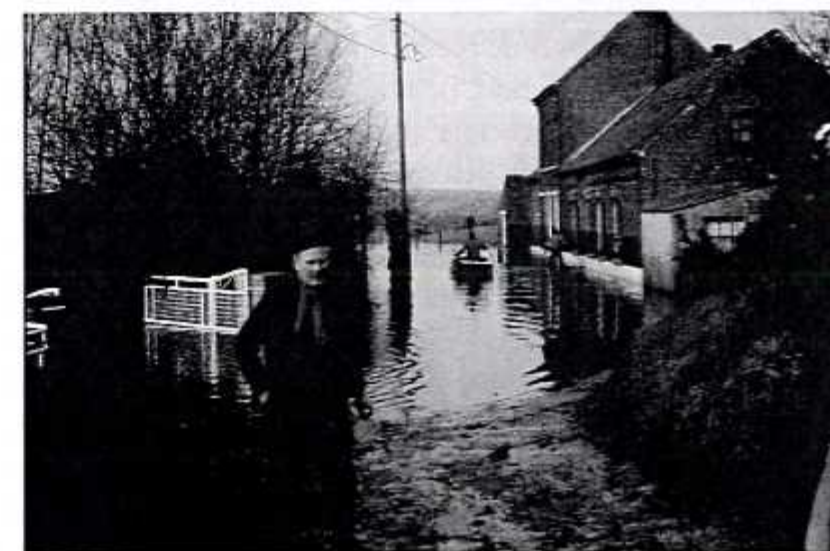
Het molenhuis in slechtere tijden: na de overstroming van 1976
